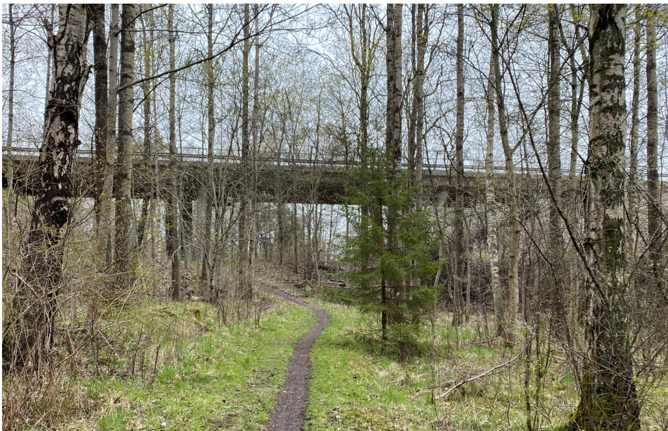
Figur 7 Stigen från Älvåsvägen till GC-vägen Rälstrampen där denna korsar under E 45
