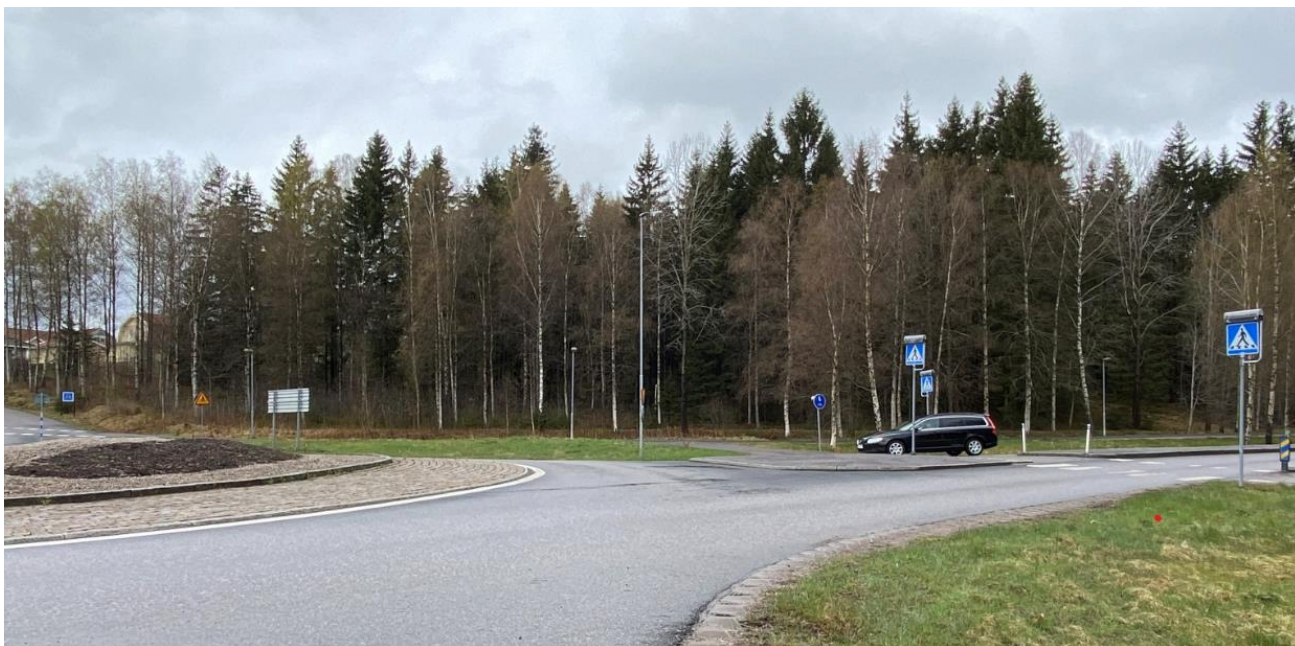
Figur 6 Övergångsställe och cykelöverfart över Vänersborgsvägen vid Hultsrondellen vid Berghöjdsvägen
